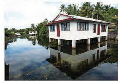
4 海面の上昇で床下まで海水が浸入する民家（ツバル、2004年） 上が干潮時、下が満潮時。
