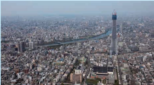
4 建設中の東京スカイツリー （2010年4月，東京都墨田区，高さ約350メートル）2012年2月の完成時の高さは634メートル。同年5月には電波塔・観光施設として開業しました。
